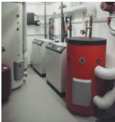
Wärmepumpen-Heizanlage für ein Mehrfamilienhaus
