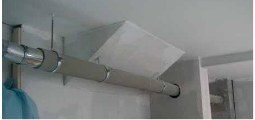
Originelle Lösung: Ein keramischer Zug liefert Wärme für das Untergeschoss.
