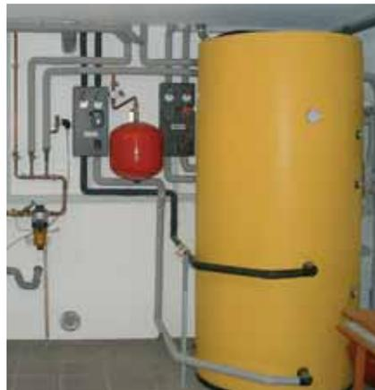
Pufferspeicher mit integriertem Warmwasserspeicher (Kombispeicher) und Wärmeverteilung im Keller.
